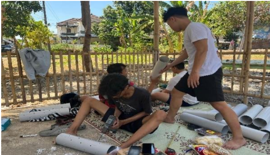
Gambar 4. Pembuatan Fasilitas Pipa Paralon Biopori
